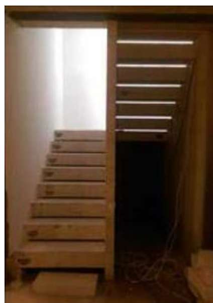
Рис. 6.3 Ступени и подступенная кладка из газобетона
