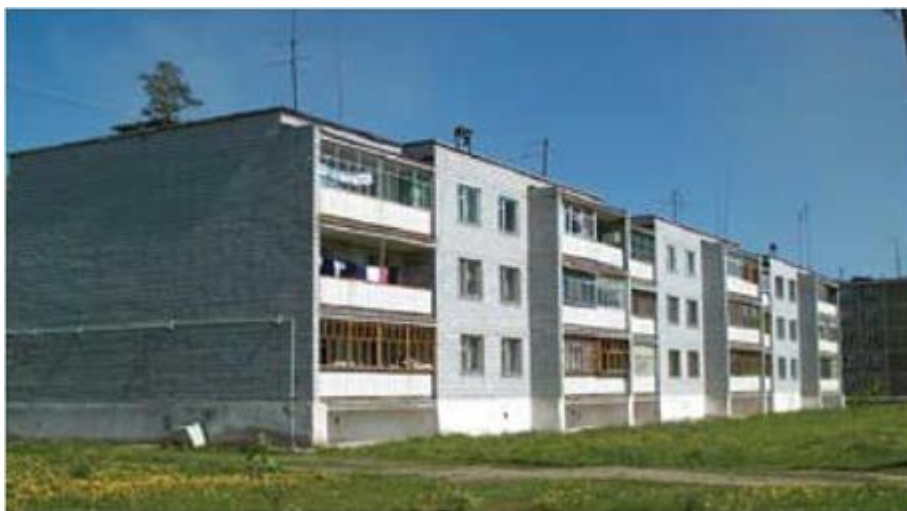
Рис. 4.1 Здание в пос. Рефтинский. 1980-е гг.
