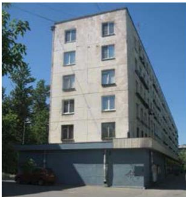
Рис. 4.3 Ленинград (Санкт-Петербург). Постройка 1961 г. Наружная отделка — окраска цементной краской без гидрофобизации
